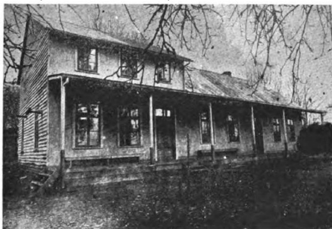
Otto Eisendecker. — Valdivia. — Casa-habitación en el Fundo «Guacamayo»
